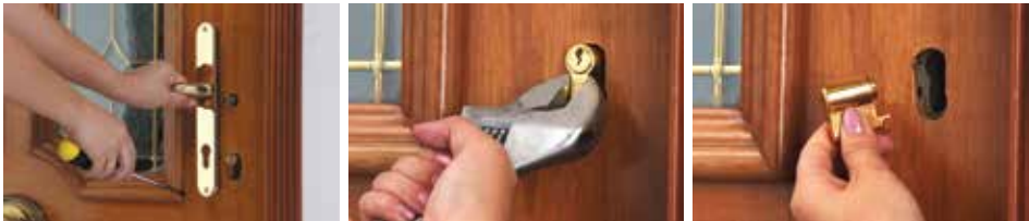
A. Remove lever plate.
